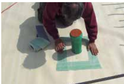
Detalle de penetración de tuberías con SikaProof® Tape-150
