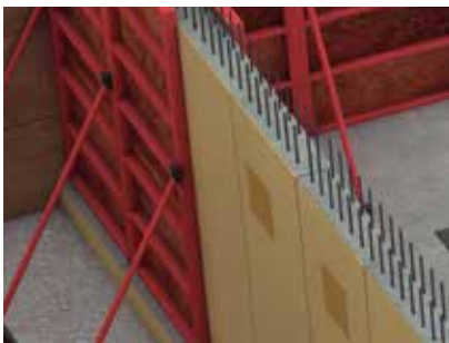
Muros con formaleta de cara doble
