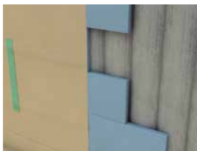
Muros, formaleta perdida
